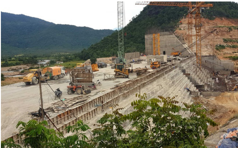
Thi công Đập chính - Hệ thống thủy lợi Tân Mỹ
