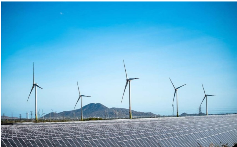
Điện gió, điện mặt trời Trung Nam tại xã Lợi Hải và Bắc Phong, huyện Thuận Bắc
