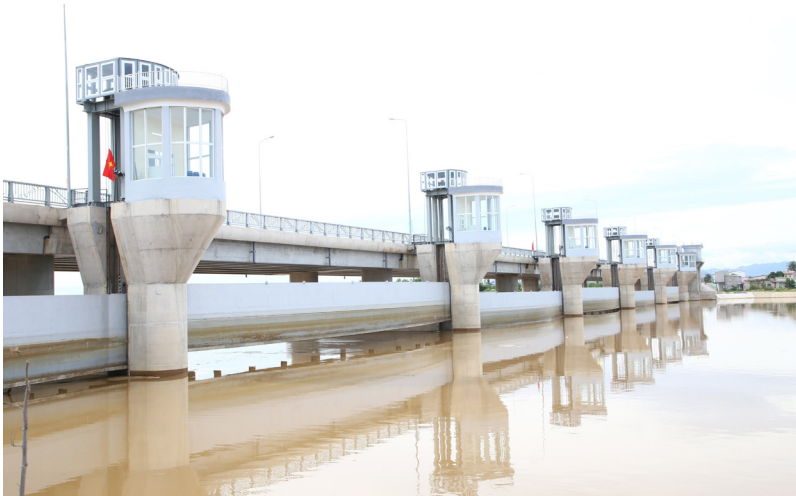
Một phần của công trình Đập hạ lưu Sông Dinh
